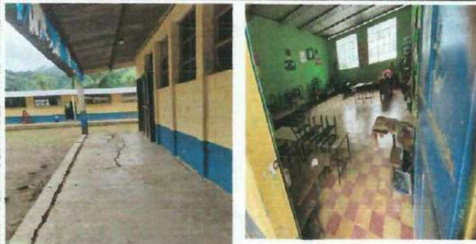
Foto 6: sustitucion de piso ceramico en 5 aulas
